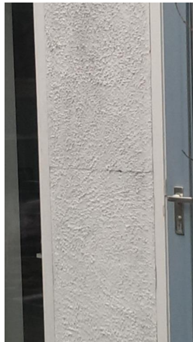
Een foto van een deel van de woning van mevrouw De Vries, met een voorbeeld van een scheur veroorzaakt door bevingsschade.
